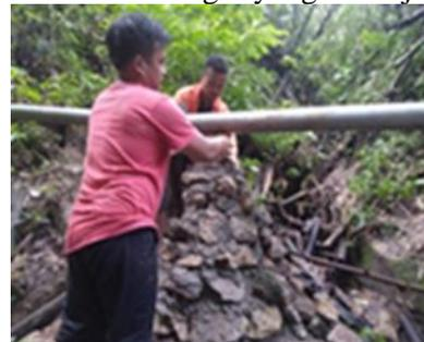
Gambar 2. Perbaikan pipa air
