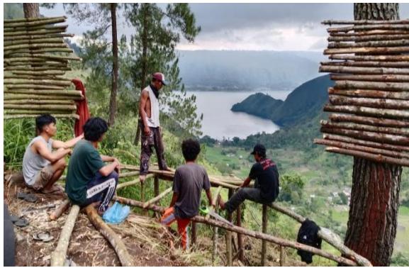
Gbr 2. Pemasangan Pondasi
