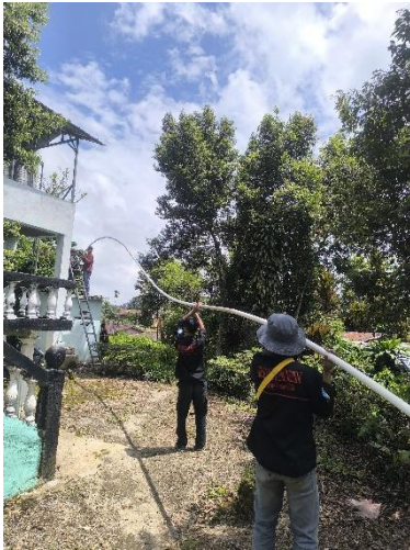
Gambar 2. Proses Instalasi dan Perbaikan
